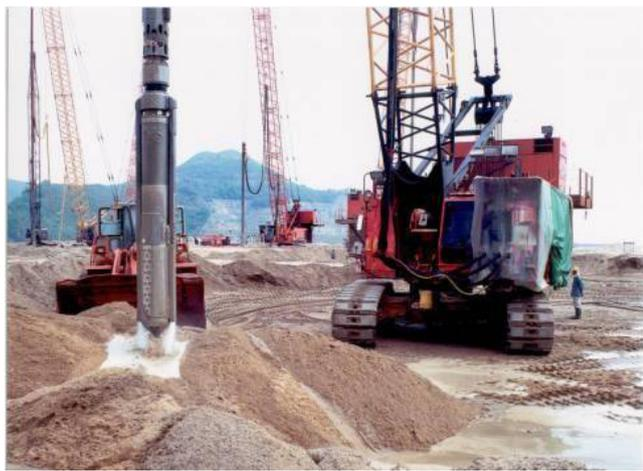
图2 振冲法施工现场示意
